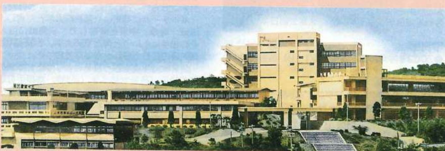
校舎を正面から見る(第1回卒業アルバムから)
