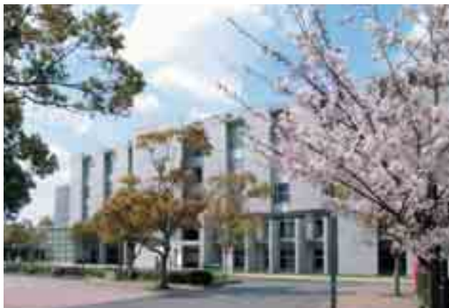
平成12年夏から翌年夏にかけて全面的に建て替えられた芸術学部棟。円筒の建物はピサの斜塔を思わせる「芸術学部アートギャラリー」。2階は保管室、1階ギャラリー横にはカフェホールが並ぶ。芸術学部のシンボル景観だ。
